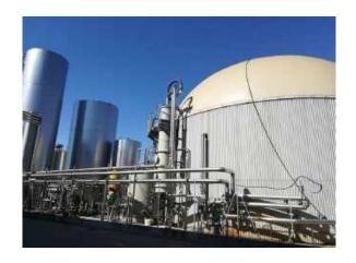
Digestore a miscelazione completa nella quale la quantità di fango anaerobico attivo viene aumentata tramite un sistema di concentrazione e riciclo dello stesso. Per fanghi o reflui con un COD compreso tra 30.000 e 150.000 mg/L.
